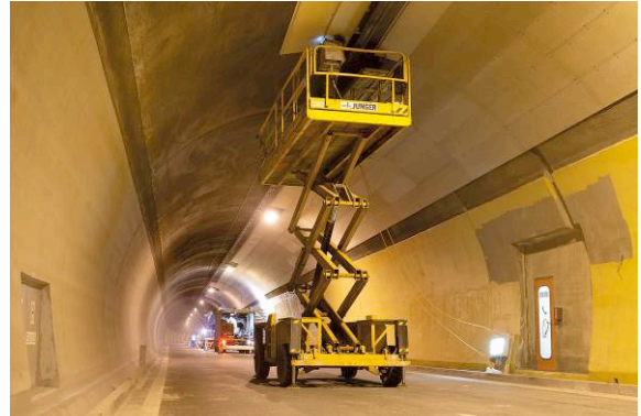
HECO_réf_internationale_Autriche_tunnel_Vorarlberg_plateforme de montage.jpg
