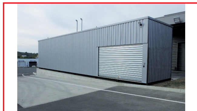
HECTRONIC pour les Ets NAULET (Baugé - 49) Vue fermée de la cuve
