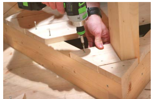
Le filet total de la vis pour plancher assure un assemblage sans fissure des planches. (photo Florian Nock)
