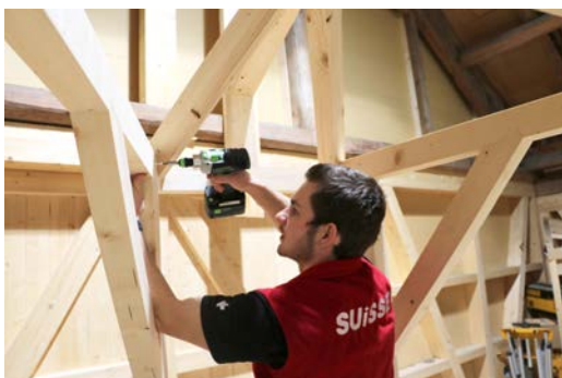
L'effet de contraction de la vis HECO-UNIX-top a facilement compensé les inégalités dans le bois, assurant des assemblages parfaits. photo Florian Nock)
