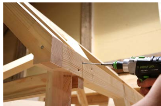
Avec les vis HECO, la fixation des différentes pièces a été 2 fois plus rapide qu'habituellement, le perçage d'avant-trous n'étant pas utile. (photo Florian Nock)
