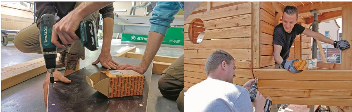
HECO-jardin d'enfants_Waldaschaff_01.jpg Renforcement de la structure de base à l'aide de panneaux en multiplis phénolique.
