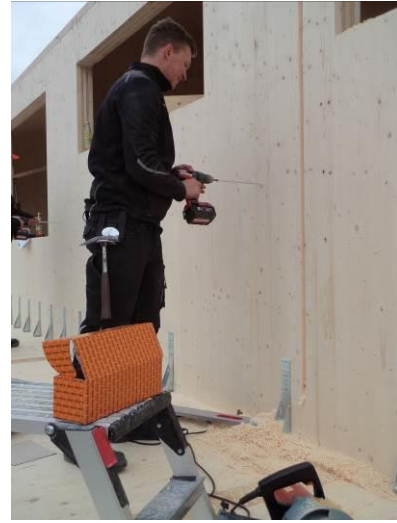
HECO-Réf_Rosenheim_fixation_des_éléments_muraux.jpg
