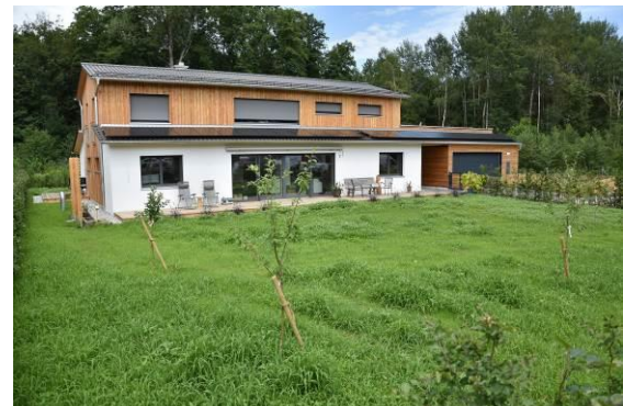
HECO-Réf_Rosenheim_maison_finalisée.jpg La maison achevée dans une construction en bois lamellé-croisé abrite une surface habitable de 360 m 2 .
